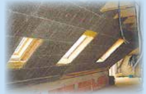
Trockenausbau und Verkleidung im Innenbereich
