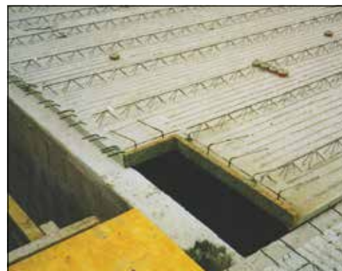
Abschalung im Randbereich bei Fertigteildecken
