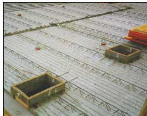
Abschalung in der Fläche
