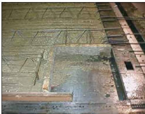
2. Betoniervorgang nach Abschalung
